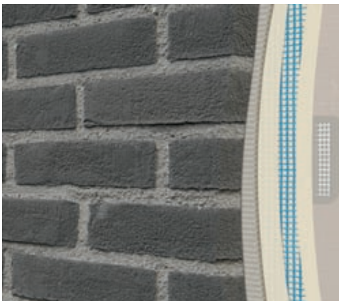
Cegły okładzinowe na elastycznym kleju
