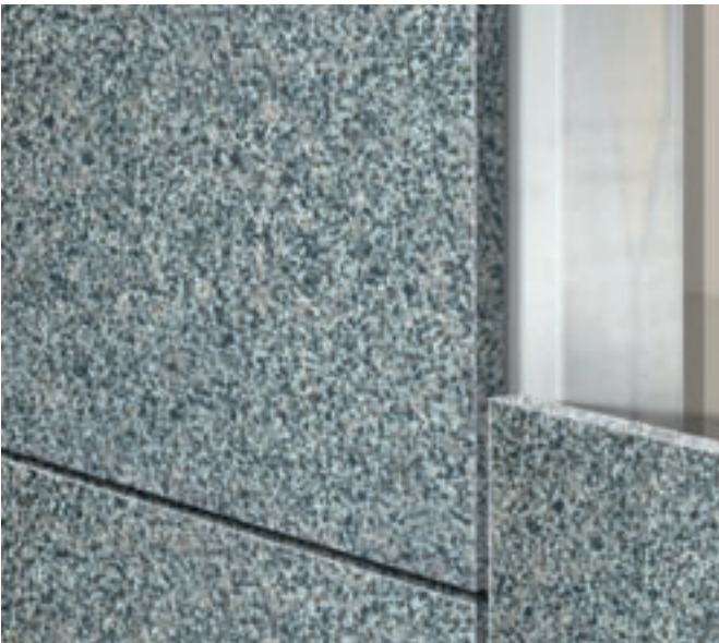
Ściana obłożona kamieniem elewacyjnym
