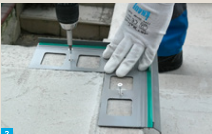
3 Przyłóż narożnik do miejsca montażu, zaznacz otwory, odłóż narożnik, wywierć otwory, osadź kołki rozporowe, pod narożniki, nałóż warstwę hydroizolacji KNAUF HF 1C, ponownie przyłóż narożnik i wkręć wkręty do połowy.
