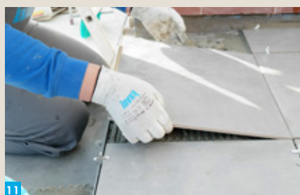
11 Ułóż płytki. Użyj wysokoelastycznego kleju Knauf K4 Elastyczny Plus.
