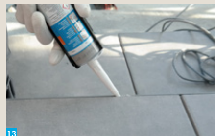
13 Wypełnij szczeliny masą elastyczną. Użyj Knauf Silikonu.
