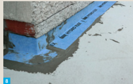
8 W taki sam sposób uszczelnij połączenia balkonu lub tarasu ze wszystkimi przylegającymi do nich ścianami.
