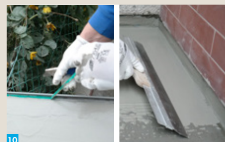
10 Po naniesieniu pierwszej warstwy hydroizolacji, usuń taśmę zabezpieczającą perforację profili. Po wyschnięciu pierwszej warstwy zaprawy uszczelniającej nanieś drugą warstwę.
