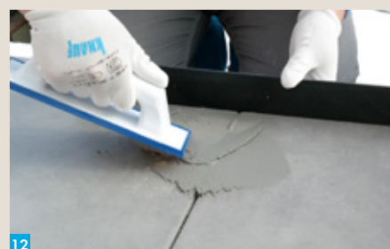
12 Do spoinowania zastosuj Knauf Fugę Elastyczną.
