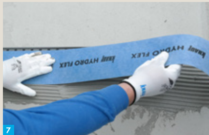
7 Nałóż hydroizolację KNAUF Hydro Flex 1C na profilach okapowych. Zatop taśmę uszczelniającą Hydro Flex w świeżo nałożonej hydroizolacji.
