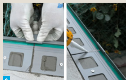
6 Zamontuj łączniki profili od góry i od dołu.
