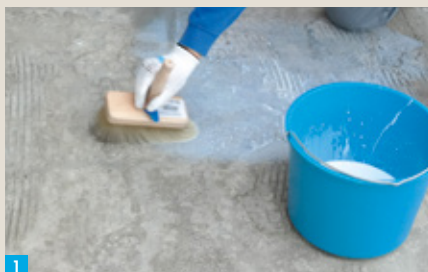
1 Zagruntuj podłoże środkiem gruntującym KNAUF Haftemulsion.
