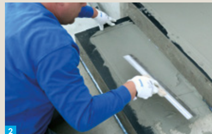
2 Zaprawą naprawczą KNAUF M1 Repair wyrównaj podłoże do wysokości szablony montażowego.
